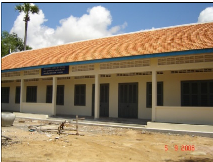
La fin du chantier de l'école maternelle de Tonlé Bati
